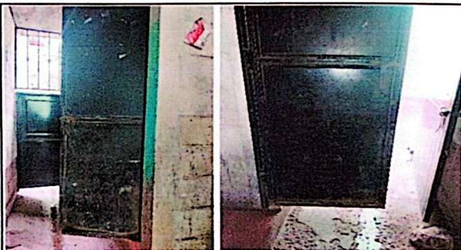
Foto 3: Sustitución de puertas en servicio sanitarios
