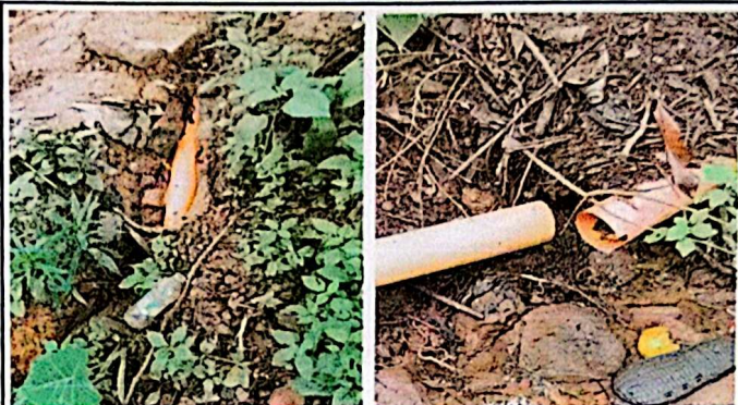
Foto 7: Sustitución de tubería PVC línea principal de aguas negras
