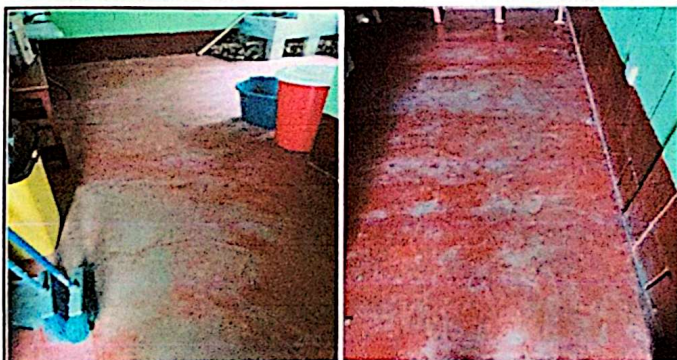
Foto 5: Sustitución de piso de torta de cemento por piso de granito
