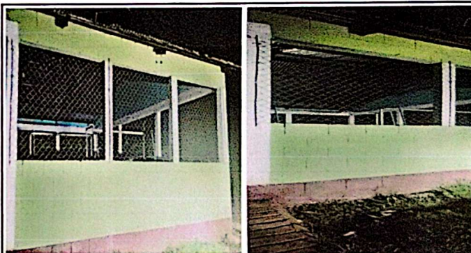
Foto 4: Sustitución de balcones de metal
