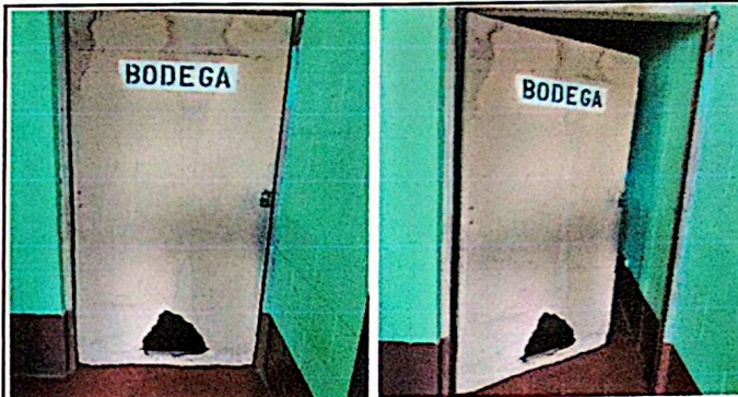
Foto 2: Sustitución de puerta de madera por metal
