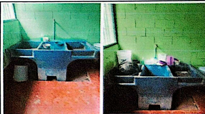
Foto 12: Sustitución de pila de dos lavaderos
