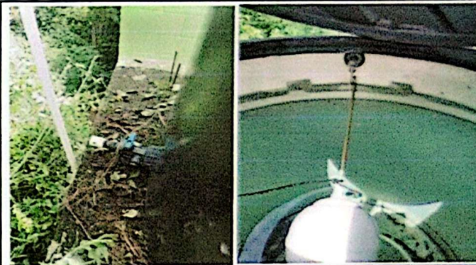
Foto 10: Sustitución de accesorios depósito de agua
