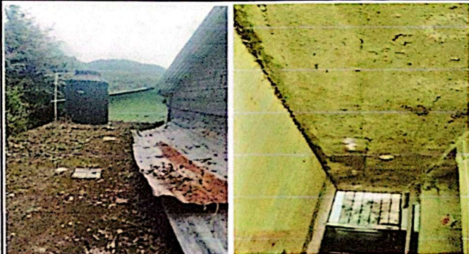
Foto1: Impearmibilización de losa
