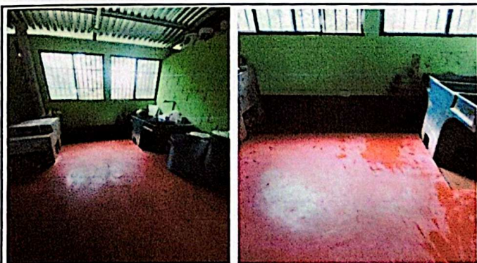
Foto 11: Mejoramiento de lavatrastos
