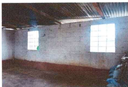
Foto 6: Sustitución de ventanas de madera por metal con vidrio
