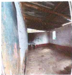
Foto 1: Sustitución de lámina por lámina troquelada aluzinc calibre 26
