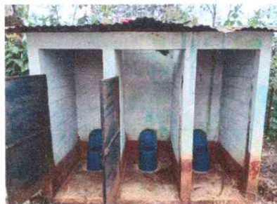
Foto 5: Sustitución de puertas de baños
