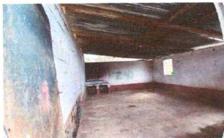
Foto 4: Sustitución de puerta de cocina
