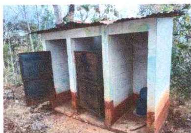
Foto 10: Sustitución de lavamanos
