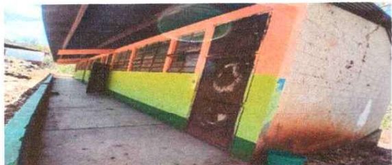
Foto 8: Pintura en muros exteriores e interiores
