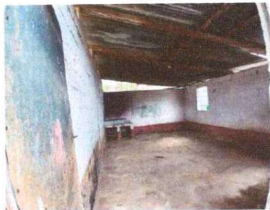
Foto 14: Sustrucción de pila plástica de dos lavaderos
