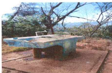
Foto 13: Sustitución de pila de cemento de dos lavaderos
