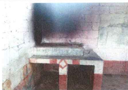
Foto 12: Sustitución de plancha de metal de 3 hornillas
