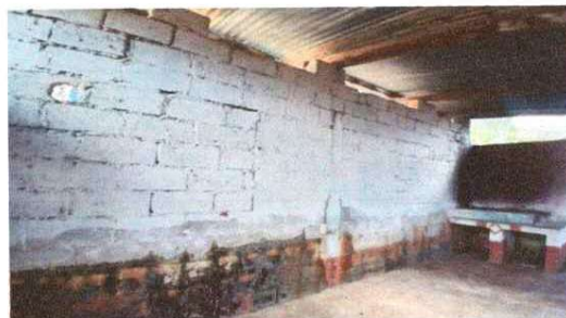
Foto 15: Repello en muro
