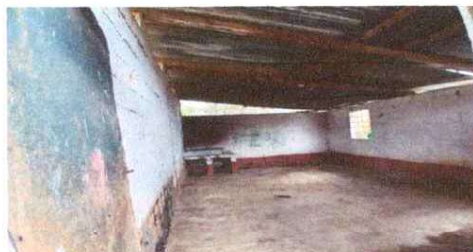
Foto 7: Sustitución de piso de granito
