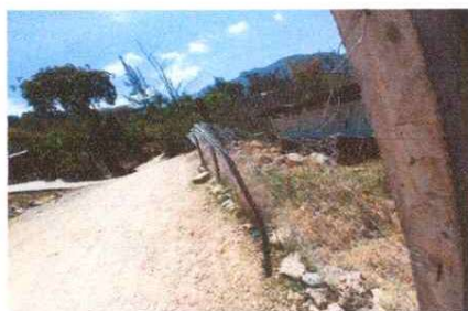
Foto 11: Reparación de tubo hg y malla galvanizada
