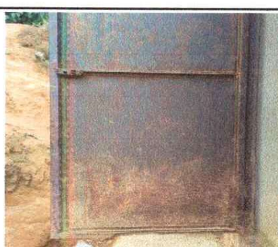
Foto 6: Sustrucción de puertas en Servicios Sanitarios.
