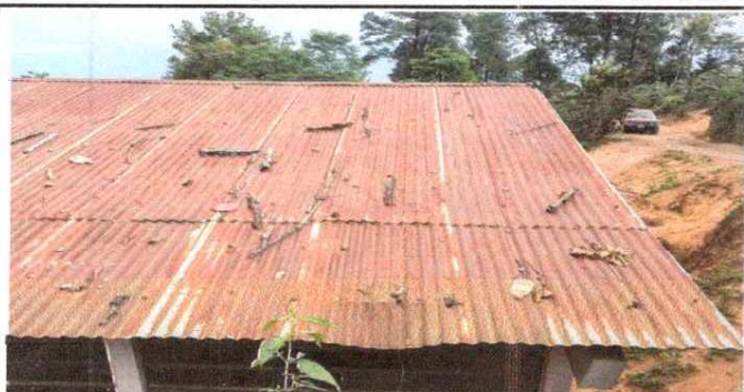
Foto 1: Sustrucción de lámina por lámina troquelada aluzic calibre 26.
