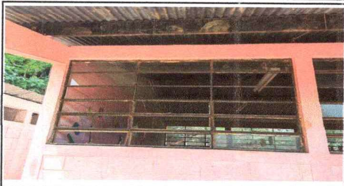
Foto 7: Sustrucción de estructura de metal de ventana más vidrio.
