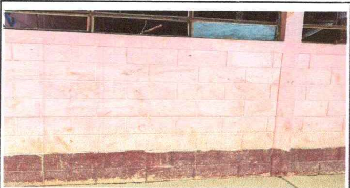
Foto 9: Pintura en muros exteriores e interiores.
