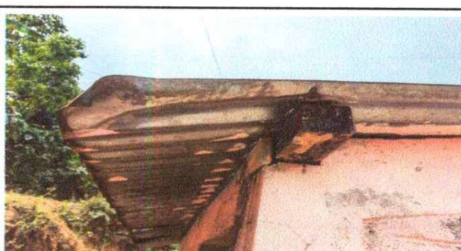
Foto 4: Sustrucción de soporte de madera por metal.
