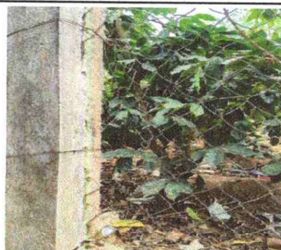
Foto 10: Reparación de malla galvanizada en muro perimetral.
