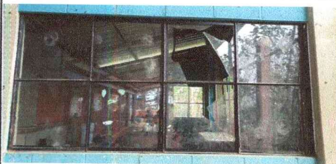
Foto 8: Sustrucción de vidrios.
