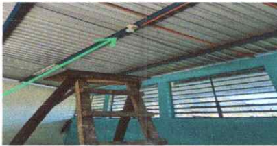
Foto 9: Sustitución de focos ahorradores y su plafoneras
