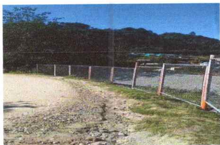
Foto1: Sustitución de malla galvanizada por malla galvanizada y tubo hg
