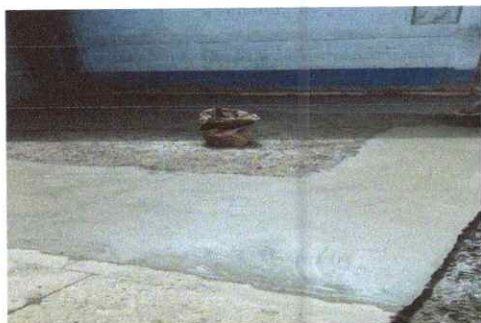
Foto 3: Sustitución de piso de torta de concreto
