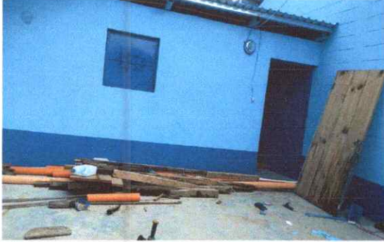
Foto 7: Sustitución de ventana de madera por metal de la dirección
