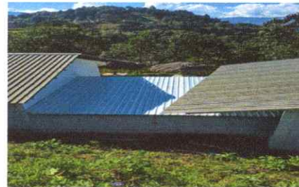
Foto 10: Sustitución de lámina, por lámina troquelada aluzinc calibre 26 y sus elementos de fijación
