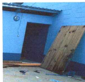
Foto 4: Sustitución de puerta con chapa de dirección (1 mt x 2.00 mts)
