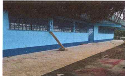
Foto 8: Sustitución vidrios, instalación de balcones en aulas
