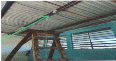
Foto 9: Sustitución de focos ahorradores y su plafoneras
