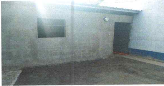
Foto 7: Proceso de sustitución de ventana de madera en dirección
