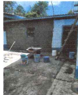
Foto 4: Sustrucción de puerta con chapa de direccón (1 mt x 2.00 mts)
