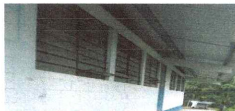
Foto 6: Sustrucción de canal de pvc, por metal y tubos pvc de bajada pluvial
