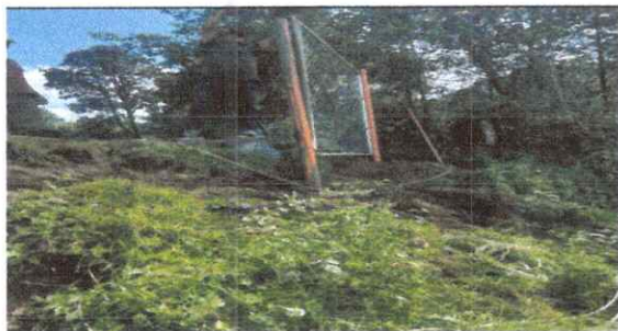
Foto 1: Sustrucción de malla galvanizada por malla galvanizada y tubo hg
