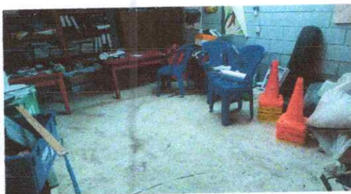
Foto 3: Sustitución de piso de torta de concreto
