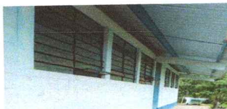
Foto 6: Sustitución de canal de pvc, por metal y tubos pvc de bajada pluvial
