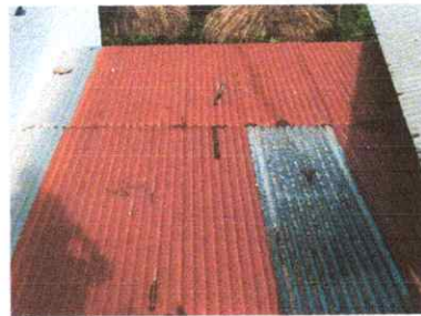
Foto 10: Sustitución de lámina, por lámina troquelada aluzinc calibre 26 y sus elementos de fijación
