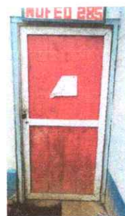
Foto 4: Sustitución de puerta con chapa de dirección (1 mt x 2.00 mts)
