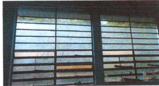
Foto 8: Sustitución vidrios, instalación de balcones en aulas
