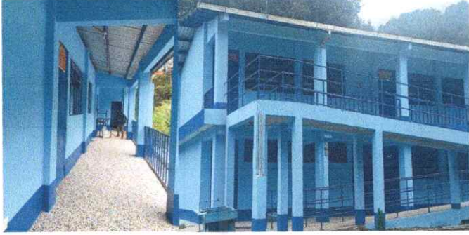
Foto1: Se logró la aplicación de pinturas en muros exteriores e interiores del establecimiento.
