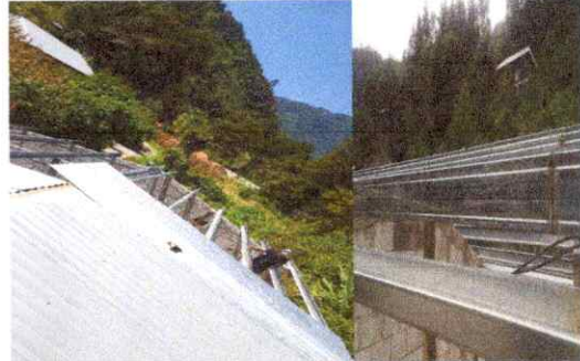
Foto 6: Estructura de soporte de metal instaladas para láminas de cocina y dirección del centro educativo.
