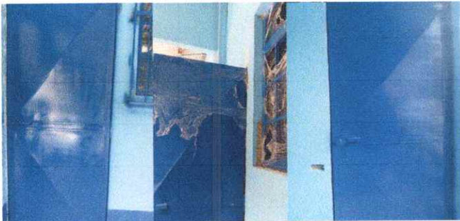
Foto 5: Puertas instaladas en el lugar correspondiente.
