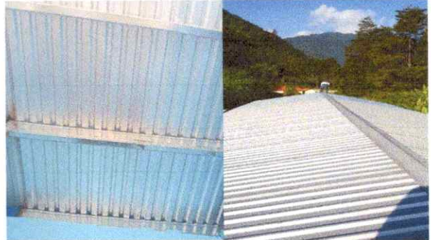
Foto 4: Instalación de láminas, por lámina troquelada aluzinc calibre 26, elementos de fijación y estructura de techo, terminado.
