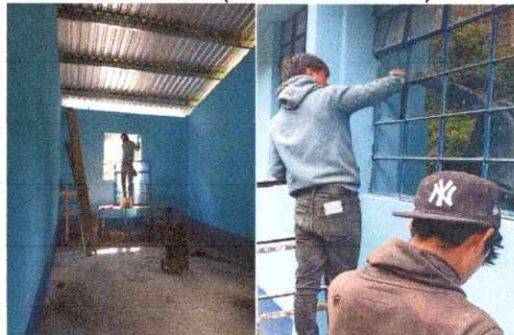
Foto 2: Instalacion de estructura de balcones y vidrios del establecimiento.
