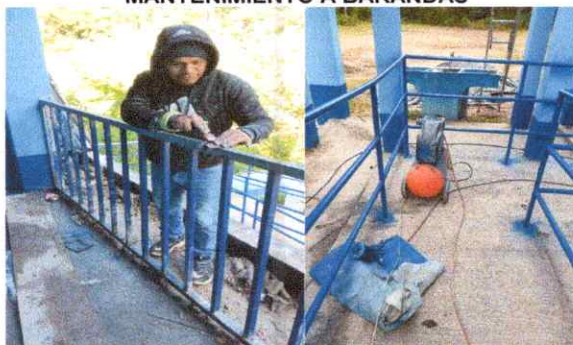
Foto 3: Proceso de manternimiento de las barandas del establecimiento
