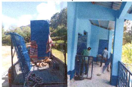
Foto 5: Entrega de puertas para su instalación de metal (2.20 m de alto * 1 m de ancho)
