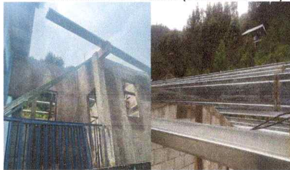
Foto 6: En proceso de sustitución de estructura de soporte de metal, por metal, de cocina y dirección del centro educativo.
