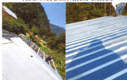
Foto 4: Trabajores en proceso de sustitución de lámina, por lámina troquelada aluzinc calibre 26, elementos de fijación y estructura de techo.
