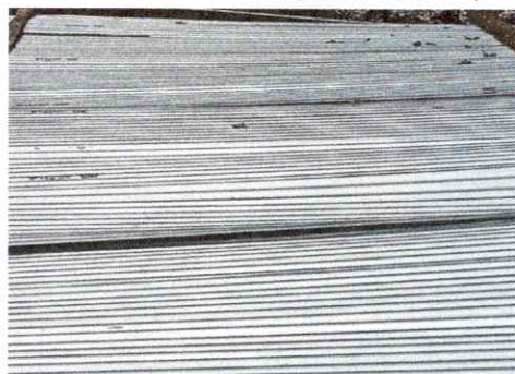
Foto 4: Sustitución de lámina, por lámina troquelada aluzinc calibre 26, elementos de fijación y estructura de techo.
