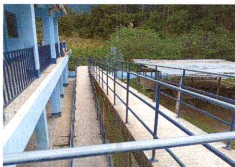
Foto 3: Mantenimiento a barandas de metal
