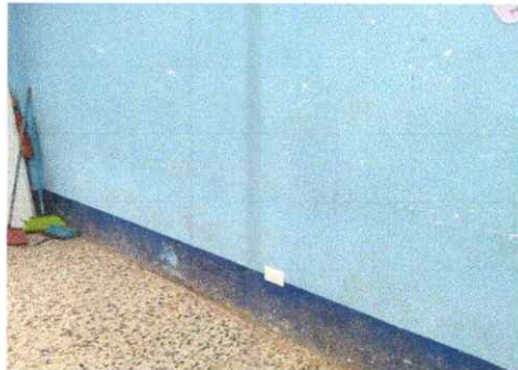
Foto 1: Pintura en muros exteriores e interiores (2 aulas + dirección + cocina)
