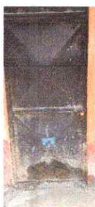
Foto 5: Sustitución de puerta con chapa por metal (2.20 m de alto * 1 m de ancho)
