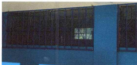
Foto 9: sustutucion de balcones de metal
