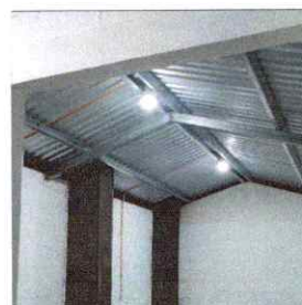
Foto 4: sustitucion de estructura de soporte de meetal, por metal
