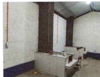
Foto 6: Mantenimiento a estufa rural, planchas de azulejos.
