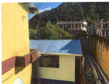
Foto 3: Sustitucion de lamina ondulada, por lamina traquelada aluzinc calibre 26 y elementos de fijacion.
