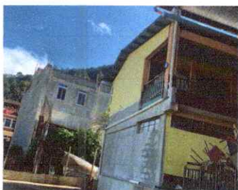
Foto 7 : Repello en muros exteriores e interiores
