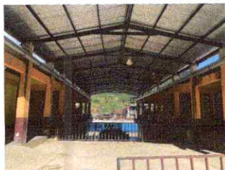
Foto 5: Susutitucion de canal de pvc , por metal y tubos de bajada pluvial.
