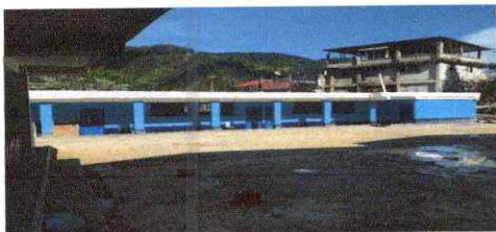
Foto1: Repello en muros exteriores e interiores.
