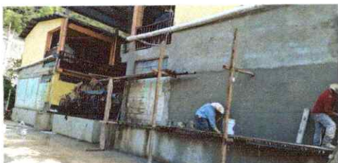
Foto7 : Repello en muros exteriores e interiores
