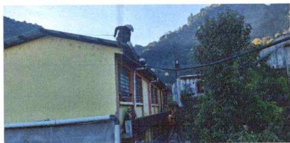
Foto 5: Susutitucion de canal de pvc , por metal y tubos de bajada pluvial.
