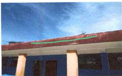
Foto 1: Repello en muros exteriores e interiores.
