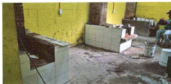
Foto 6: Mantenimiento a estufa rural, planchas de azulejos.
