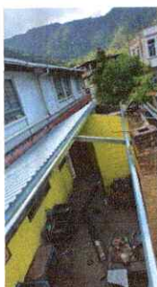
Foto 3: Sustitucion de lamina ondulada, por lamina traquelada aluzinc calibre 26 y elementos de fijacion.
