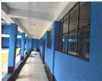
Foto 9: sustutucion de balcones de metal
