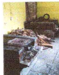
Foto 6: Mantenimiento a estufa rural, planchas y azulejos
