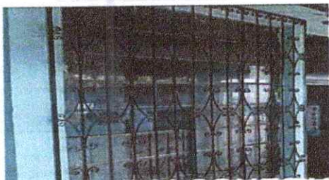
Foto 9: Sustitución de balcones de metal
