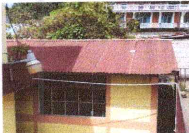
Foto 3: Sustitución de lámina ondulada, por lámina troquelada aluzinc calibre 26, capotes y elementos de fijación
