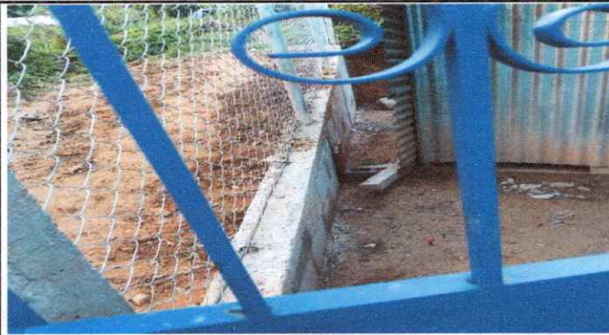
Foto 2: Portón de metal( muro perimetales)
