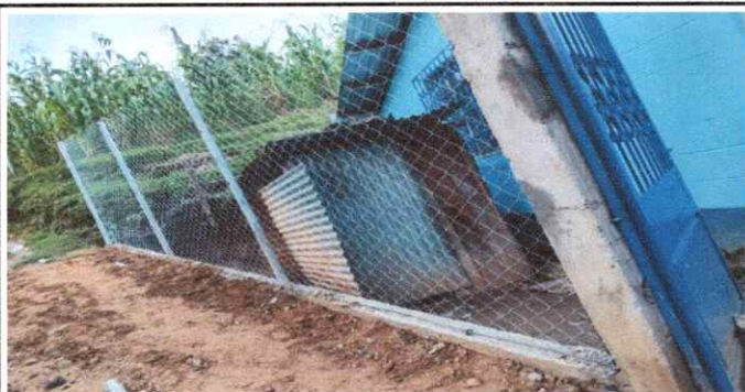
Foto 5: Maya y tubo galvanizada( muro perimetral)
