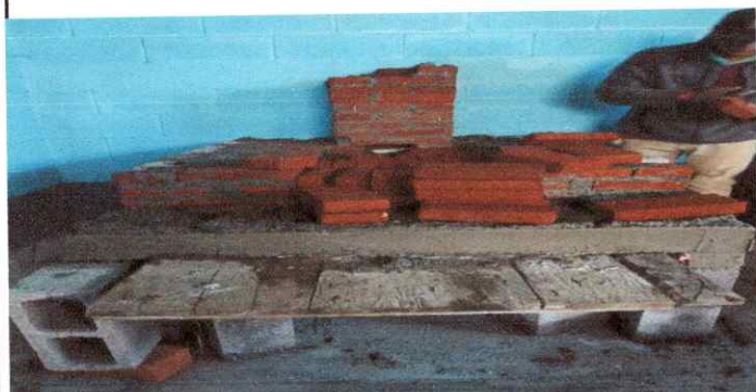
Foto1: CONSTRUCCION DE ESTUFA RURAL( cocina)
