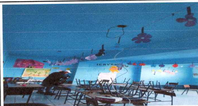
Foto 5: Instalación de nuevos cableados (aula)
