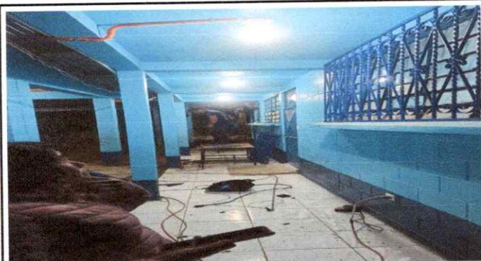
Foto 3: Instalación de plafoneras(corredor)
