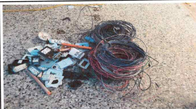
Foto 4: Cambio de cableado (aulas)
