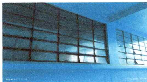
Foto 6: Fabricación e instalaciones de balcones en aulas, bodegas y dirección.
