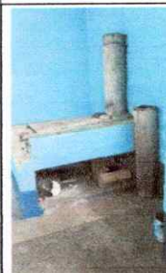
Foto 4: Sustrucción de estufa rural completa, lavatrastes y mesa de cocina con azulejos
