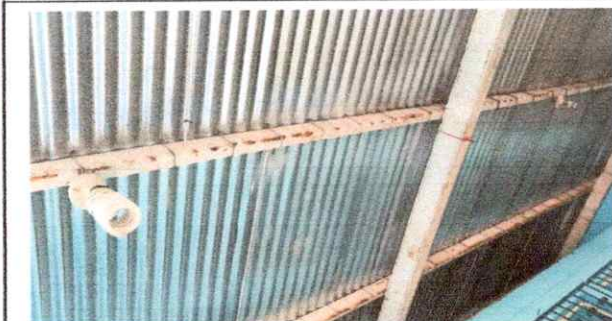
Foto 1: Sustrucción del cableado, ducto eléctrico, focos, plafoneras, interruptores simples y dobles, tomacorrientes, tablero de flipon y flipon.
