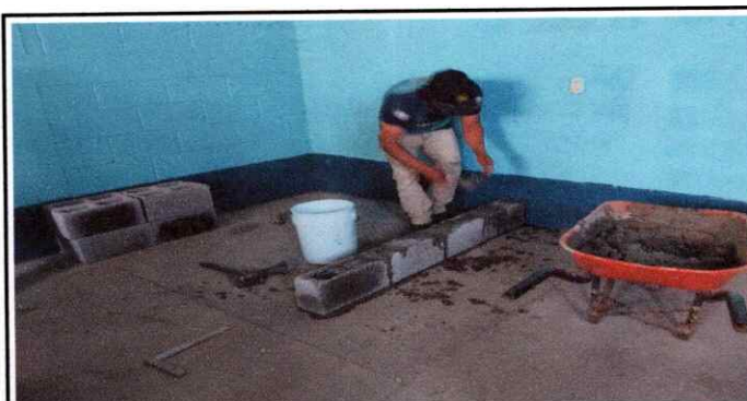
Foto 6: CONSTRUCCIÓN DE LA ESTUFA RURAL (cocina)
