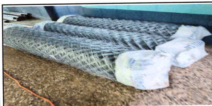
Foto 3: RECEPCIÓN DE MAYA( muro perimetral)
