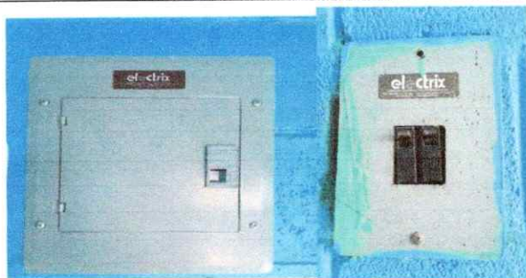
Foto 5: sustitución de tablero
