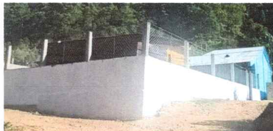
Foto 4: Repello y pinturas en muros interiores y exteriores del muro perimetral, aulas, cocina y dirección.
