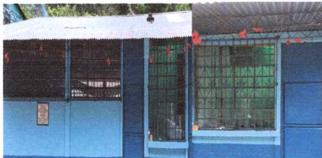
Foto 3: Sustitución de vidrios en ventanas de aula y dirección por unidad con balcones.
