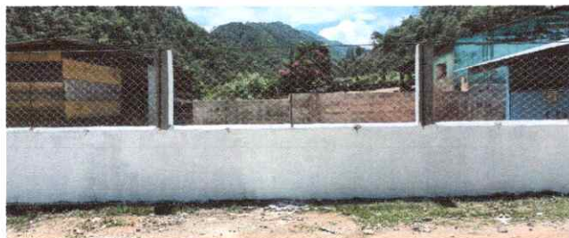
Foto 5: Sustitución de malla galvanizada y columnas.
