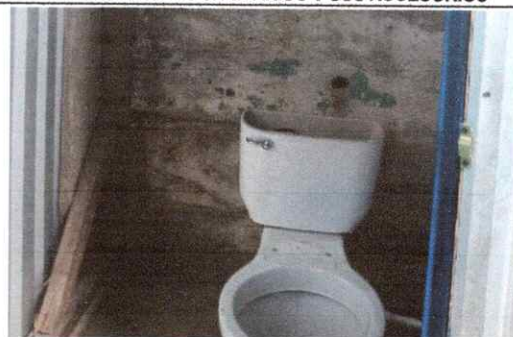
Foto 2: Sustitución de inodoros con accesorios completos.
