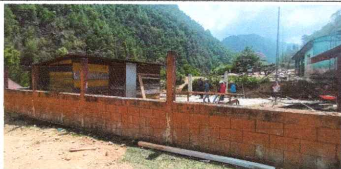
Foto 5: Sustitución de malla galvanizada y columnas.
