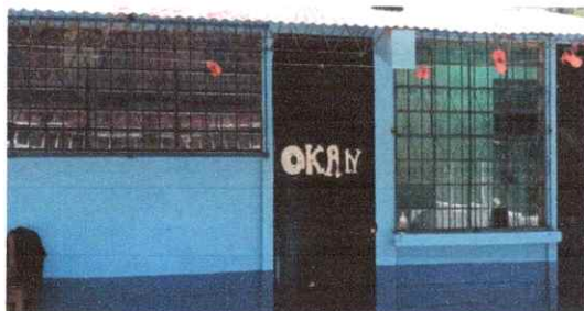
Foto 3: Sustitución de vidrios en ventanas de aula y dirección por unidad con balcones.
