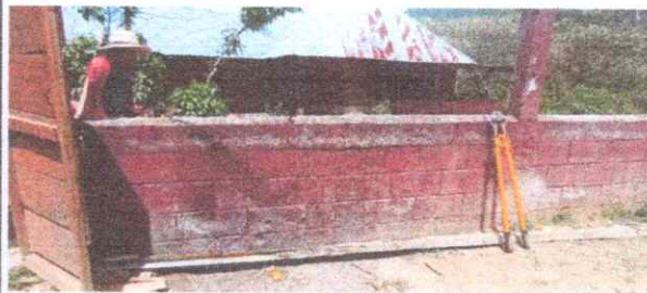
Foto 4: Repello y pinturas en muros interiores y exteriores del muro perimetral, aulas, cocina y dirección.
