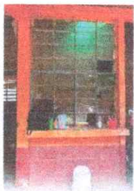
Foto 3: Sustitución de vidrios en ventanas de aula y dirección por unidad con balcones.
