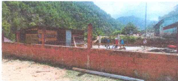
Foto 5: Sustitución de maila galvanizada y columnas.
