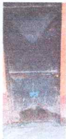
Foto 1: Sustitución de puertas de metal y madera por metal de 2 aulas+ cocina+ servicios sanitarios y portones
