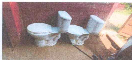
Foto 2: Sustitución de inodoros con accesorios completos.
