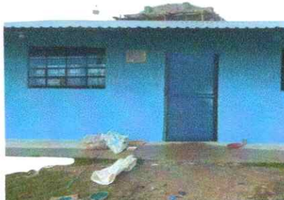
Foto 2: Sustitución de puertas de metal, por metal
