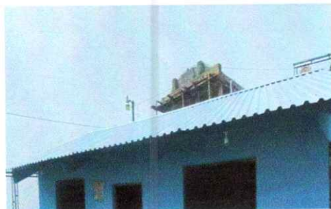
Foto 5: Sustitución de canal de pvc, por metal y tubos de bajada pluvial
