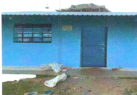
Foto 9: Sustitución de 2 ventanas de metal por metal (1 mt de alto * 1.50 mt de ancho)
