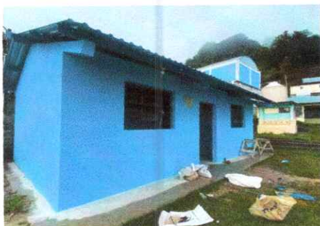
Foto 7: Repello en muros exteriores e interiores
