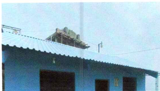
Foto 3: Sustitución de lámina ondulada, por lámina troquelada aluzinc calibre 26, capotes y elementos de fijación
