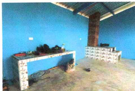
Foto 6: Sustitución de estufa rural (completa) incluye chimenea y plancha de metal, azulejos de pila y mesa
