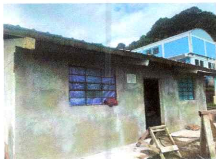
Foto 3: Sustitución de lámina ondulada, por lámina troquelada aluzinc calibre 26, capotes y elementos de fijación
