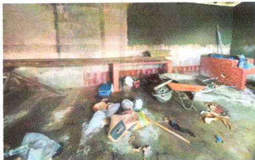
Foto 7: Repello en muros exteriores e interiores
