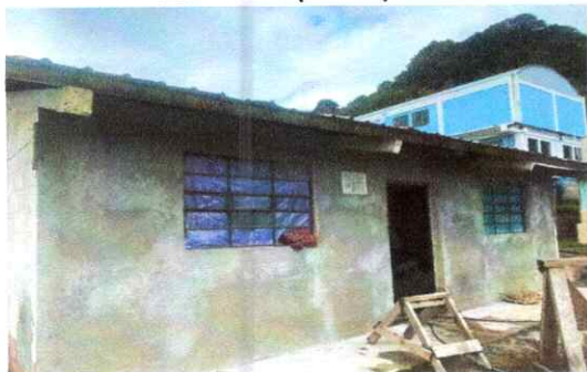
Foto 9: Sustitución de 2 ventanas de metal por metal (1 mt de alto * 1.50 mt de ancho)
