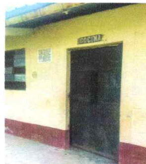
Foto 2: Sustitución de puertas de metal, por metal
