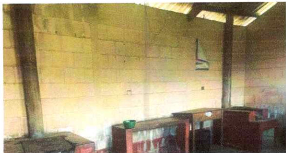
Foto 7: Repello en muros exteriores e interiores
