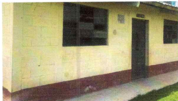
Foto 9: Sustitución de 2 ventanas de metal por metal (1 mt de alto * 1.50 mt de ancho)
