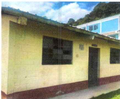
Foto 3: Sustitución de lámina ondulada, por lámina troquelada aluzinc calibre 26, capotes y elementos de fijación
