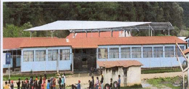
Foto 4: Sustitución de láminas
