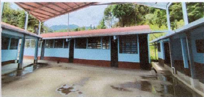
Foto 3: Sustitución de láminas
