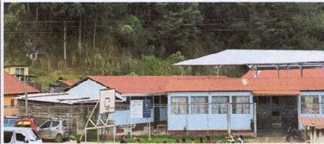
Foto 2: Sustitución de láminas
