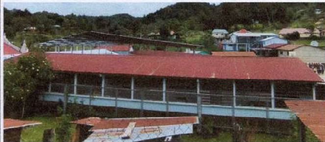
Foto1: Sustitución de láminas
