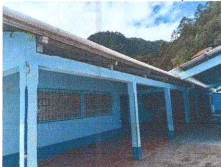
Foto 5: Sustitución de canal de pvc (tubos, codos, tee)
