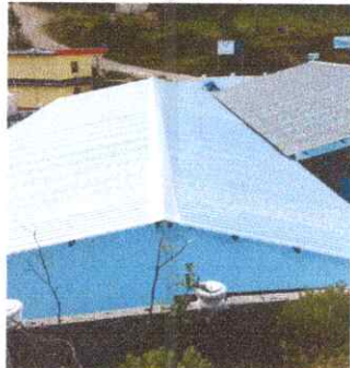
Foto 1: Sustitución de lámina tip teja, por lámina troquelada aluzinc calibre 26 color gris metálico
