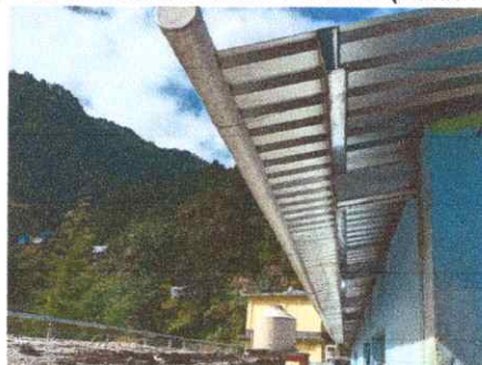
Foto 6: Sustitución de bajada de agua pluvial de tubo PVC 3", por tubo PVC 3" (codos + tee)
