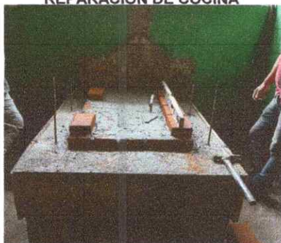
Foto 3: Sustitución de estufa rural (completa) incluye chimenea y plancha de metal
