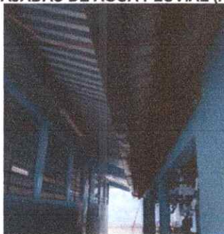
Foto 5: Sustitución de canal de pvc (tubos, codos, tee)
