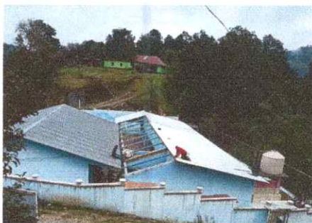
Foto 1: Sustitución de lámina tip teja, por lámina troquelada aluzinc calibre 26 color gris metálico
