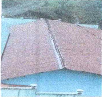
Foto1: Sustitución de lámina tip teja, por lámina troquelada aluzinc calibre 26 color gris metálico
