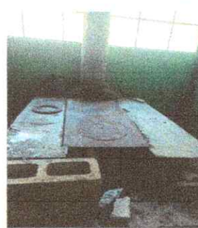
Foto 4: Sustitución de estufa rural (completa) incluye chimenea y plancha de metal
