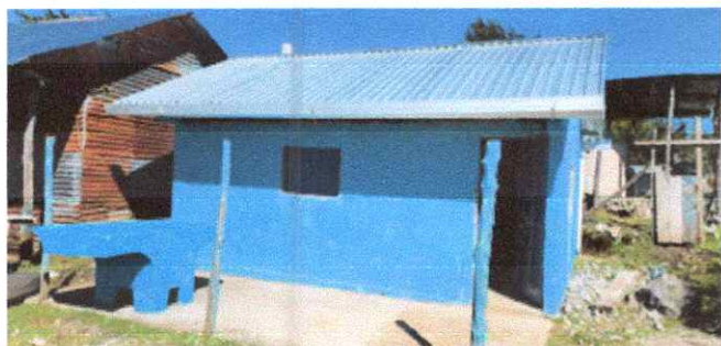
Foto 9: Techo reconstruido de cocina, junto a su cubierta de lamina ondulada a lámina troquelada calibre 26, estructura de soporte de madera sustituida a soporte de metal con costaneras.
