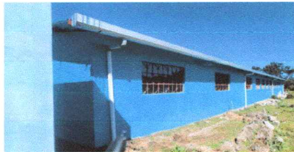
Foto 8: Techo ya con avance de sustitución de lamina troquelada calibre 26, capotes y tornillos de fijacion
