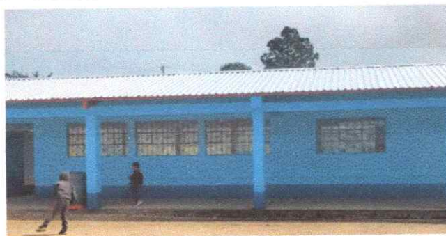
Foto 10. Aulas, bodega, y dirección fachada con muros exteriores pintados, canaletas instaladas con bajantes pluviales..
