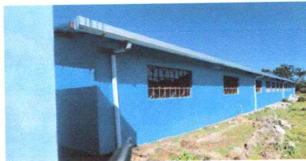
Foto 8: Aulas, bodega y dirección pintado en su exterior, con bajantes pluviales y canaletas, parte posterior.
