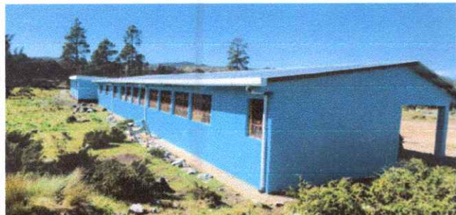
Foto 7: Aulas, bodega y direccion con techo en proceso de sustitucion delamina ondulada a lamina zin a troquelada calibre 26.
