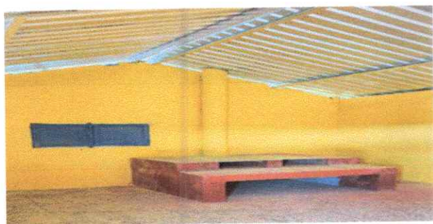
Foto 9: Techo reconstruido de cocina, junto a su cubierta de lamina ondulada a lámina troquelada calibre 26, estructura de metal, muros interiores pintados y ventanas, y puerta instalada.
