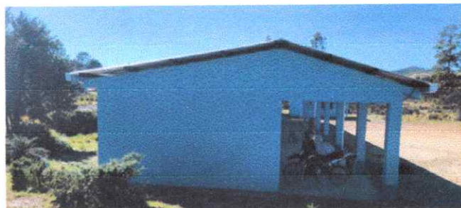
Foto 2: Pintura en muros exteriores e interiores
