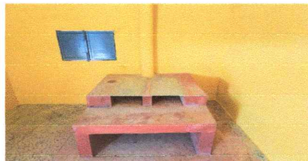
Foto 10. Plancha para cocinar en proceso de construccion desde cero para una mejor forma de cocinar a las madres de familia.
