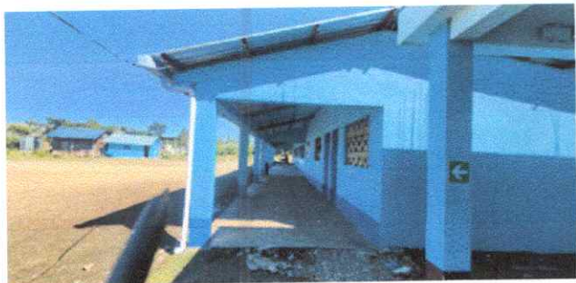
Foto 7: Aulas, bodega y dirección con techo lamina zin a troquelada calibre 26. bajantes pvc y canaletas, con muros exteriores pintados
