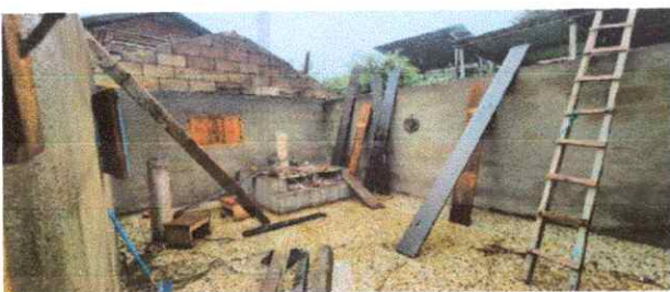
Foto 5: Sustitución de estructura de soporte de madera, por metal
