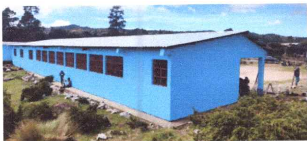
Foto 7: Aulas, bodega y direccion con techo en proceso de sustitucion delamina ondulada a lamina zin a troquelada calibre 26.
