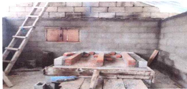
Foto 12: Pintado de muros de la cocina y sustitucion de ventanas y puertas de madera a metal en proceso mientras se construye la estufa rural.
