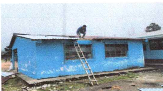
Foto1: Sustitución de lámina ondulada, por lámina troquelada aluzinc calibre 26, capotes y elementos de fijación
