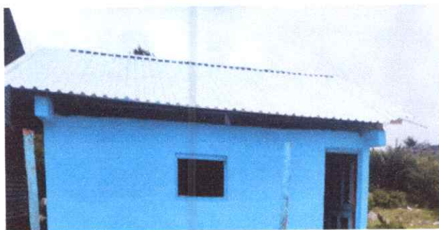
Foto 9: Techo reconstruido de cocina, junto a su cubierta de lamina ondulada a lámina troquelada calibre 26, estructura de soporte de madera sustituido a soporte de metal con costaneras.
