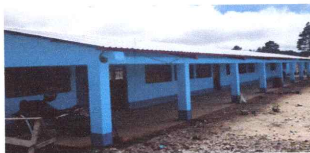
Foto 8: Techo ya con avance de sustitución de lamina troquelada calibre 26, capotes y tornillos de fijacion
