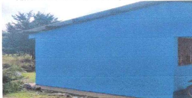
Foto 2: Pintura en muros exteriores e interiores
