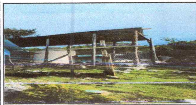
Foto 11: Deposito de agua necesita ser sustituido y reemplazar accesorios para su instalacion, asi como pila de concreto de dos lavamanos.
