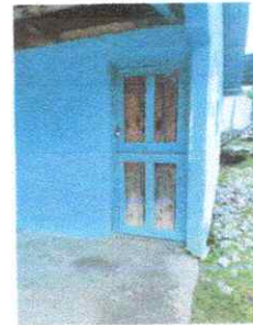
Foto 8: Sustrución de puerta de madera por metal
