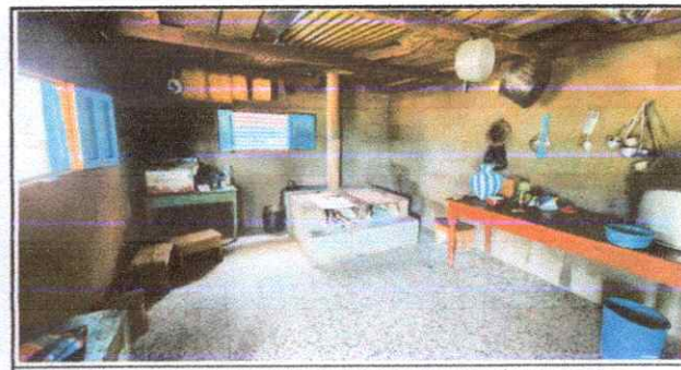
Foto 12: Pintado de muros de la cocina y sustitucion de ventanas y puertas de madera a metal.
