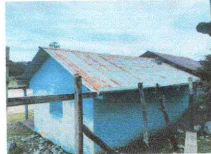
Foto 10: Sustrución de canal de pvc, por metal y de bajada de agua pluvial de tubo PVC 3, por tubo PVC 3
