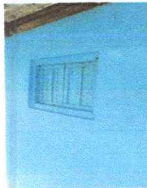
Foto 11: Sustrución de ventanas de madera por estructura de metal
