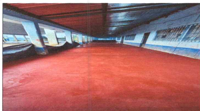
INSTALACION DE TORTA DE PISO
