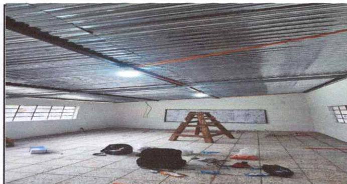
REPELLO, LUZ E INSTALACION DE GRANITO EN AULA
