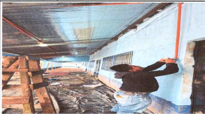
INSTALACION DE LUZ
