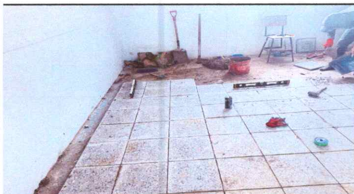
FOTO 3: INSTALACIÓN DE GRANITO EN AULA
