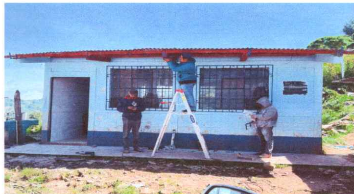
FOTO 4: INSTALACION DE PESCANTE
