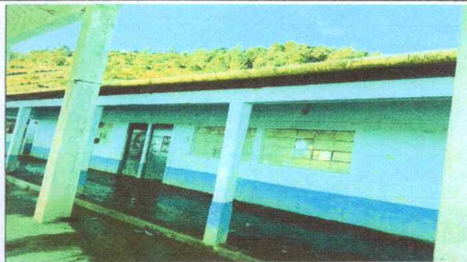
FOTO 8: SUSTITUCIÓN DE CANAL Y REPARACIÓN DE BAJADA DE AGUA PLUVIAL
