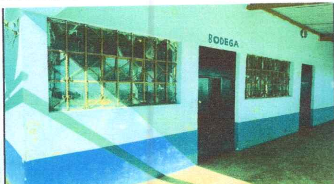
Foto 3: PINTURA MUROS EXTERIORES
