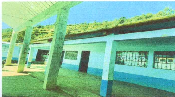
FOTO 10: SUSTITUCIÓN DE CANAL Y REPARACIÓN DE BAJADA DE AGUA PLUVIAL
