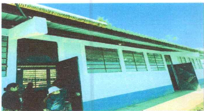
FOTO 15: PINTURA MURO EXTERIOR Y SUSTITUCIÓN DE CANAL Y REPARACIÓN DE BAJADA DE AGUA PLUVIAL
