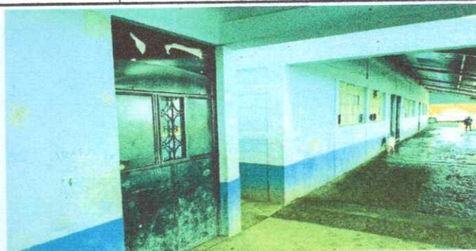
FOTO 2: PINTURA MUROS EXTERIORES Y REPARACION DE PLANCHAS DE CONCRETO
