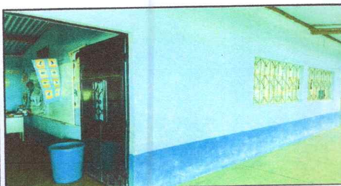
Foto 5: PINTURA MUROS EXTERIORES
