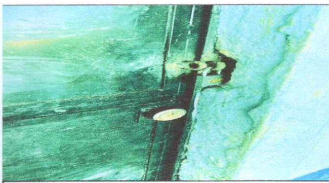
FOTO 16: SUSTITUCION DE CHAPA (1)
