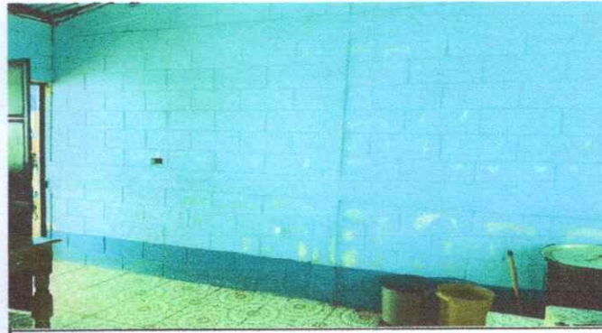
FOTO 12: REPELLO EN MURO DE COCINA
