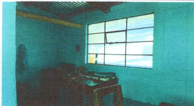
FOTO 13: REPELLO EN MURO DE COCINA
