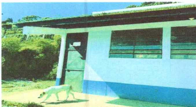
FOTO 13: PINTURA MURO EXTERIOR Y SUSTITUCIÓN DE CANAL Y REPARACIÓN DE BAJADA DE AGUA PLUVIAL
