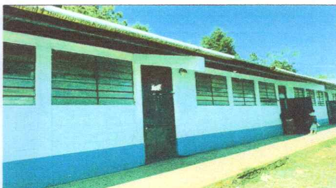
FOTO 14: PINTURA MURO EXTERIOR Y SUSTITUCIÓN DE CANAL Y REPARACIÓN DE BAJADA DE AGUA PLUVIAL
