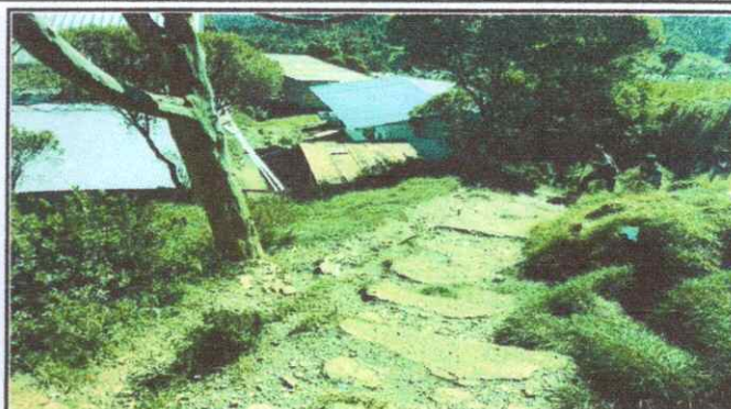
FOTO 14: SUSTITUCION DE PISO DE TORTA DE CONCRETO
