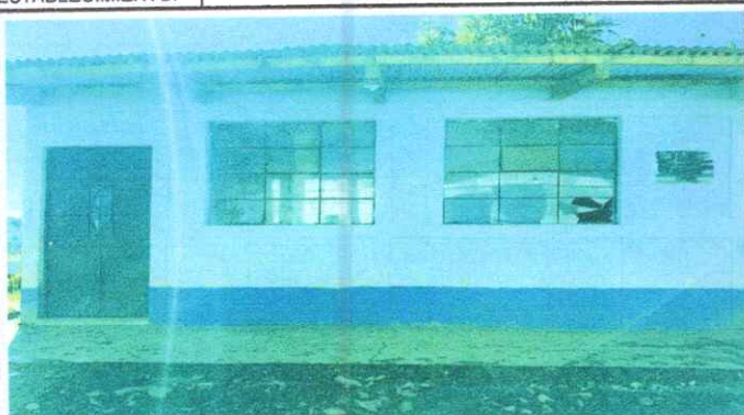
FOTO 1: SE NECESITA INSTALACIÓN DE BALCONES DE METAL, APLICACIÓN DE PINTURA DE EXTERIOR, INSTALACIÓN DE SOPORTE O PESCANTE DE PVC PARA CANAL Y BAJADA DE AGUA
