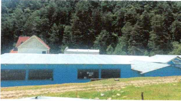
Foto 1: Sustitución de lámina ondulada, por lámina troquelada aluzinc calibre 26 color gris metálico, capotes y elementos de fijación.
