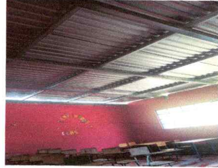
Foto 2: Sustitución de estructura de soporte de madera, por metal de dos aulas y dirección.
