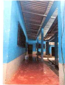
Foto 4: Estructura de techos de pasitos, aulas y dirección.
