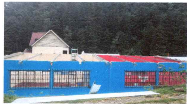
Foto 4: Sustitución de estructura de soporte de madera, por metal de dos aulas y dirección.
