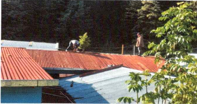
Foto 1: Sustitución de lámina ondulada, por lámina troquelada aluzinc calibre 26 color gris metálico, capotes y elementos de fijación.
