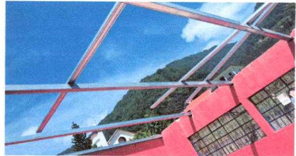
Foto 2: Sustitución de estructura de soporte de madera, por metal de dos aulas y dirección.
