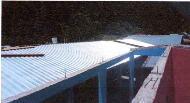
Foto 3: Sustitución de lámina ondulada, por lámina troquelada aluzinc calibre 26 color gris metálico, capotes y elementos de fijación.
