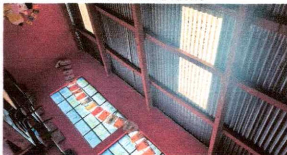
Foto 2: Sustitución de estructura de soporte de madera, por metal de dos aulas y dirección.
