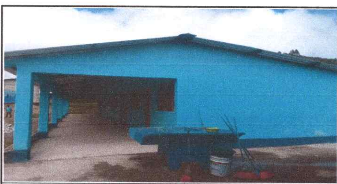
Foto 6: Cambio de piso torta, por piso granito en todo el edificio escolar finalizado
