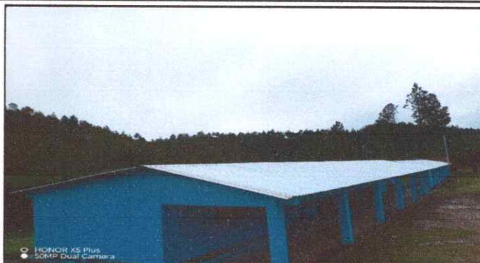
Foto 2: sustitucion del techo en finalización
