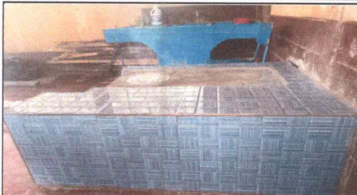
Foto1: Sustrución de planchas en finalización
