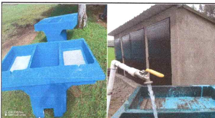
Foto 4: Sustrución de tubería general de agua desde el naciminetto hasta el Estableciminetto con pilas para almacenar agua en finalización
