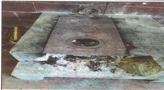
Foto1: Sustitución de planchas en proceso
