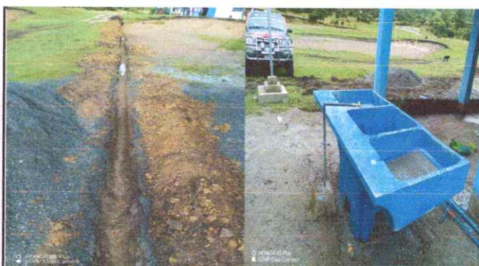
Foto 4: Sustitución de tubería general de agua desde el naciminetto hasta el Estableciminetto con pilas para almacenar agua en proceso
