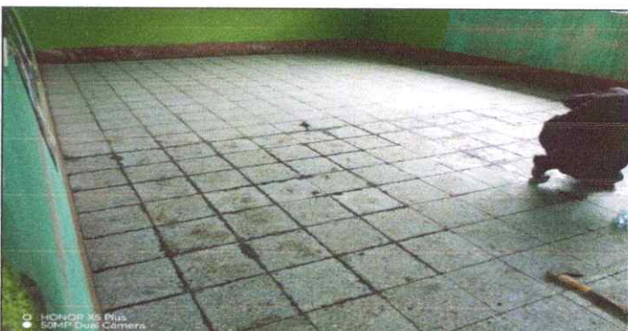
Foto 6: Cambio de piso torta, por piso granito en todo el edificio en proceso
