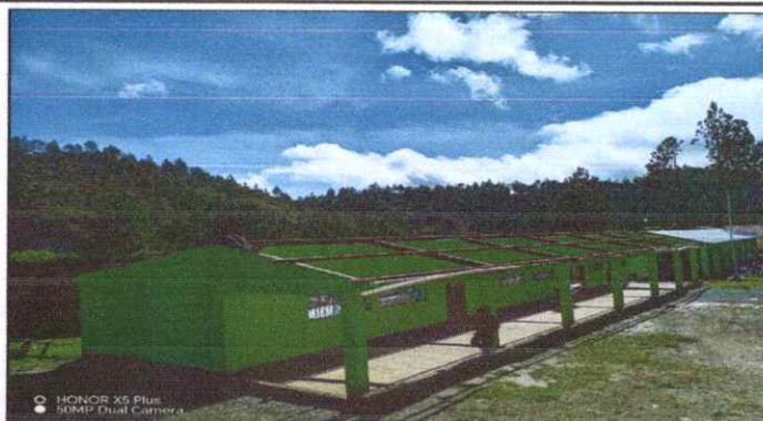
Foto 2: sustitucion del techo en proceso
