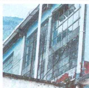
Foto 4: Repello en muros exteriores (2 aulas)
