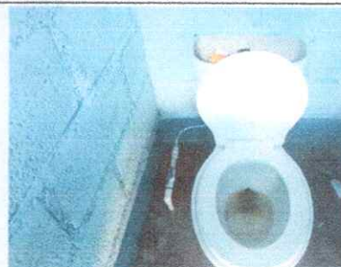
Foto 2: Sustitución inodoro (con accesorios completos)
