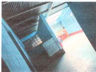
Foto 1: Pintura en muros exteriores e interiores (aula + dirección + servicios sanitarios y pila)
