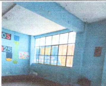
Foto 5: Sustitución de vidrios en ventanas de aulas (54 cm x 69 cm)
