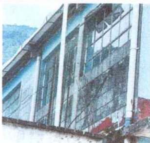
Foto 3: Instalación de canal de pvc (tubos, codos, tee)
