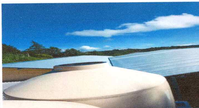
Foto 3: Sustrucción de depósito de agua
