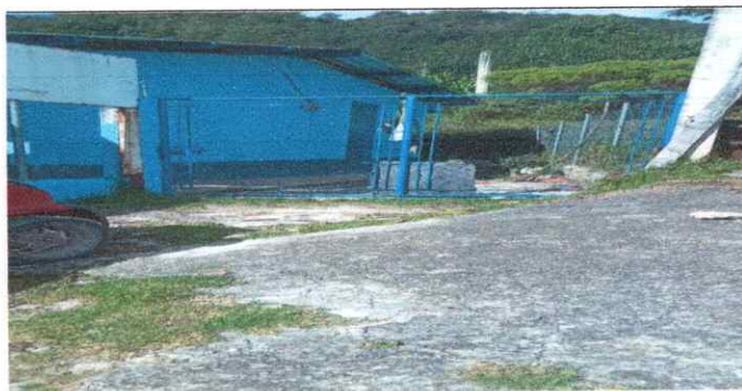
Foto 6: Mantenimiento de portón.
