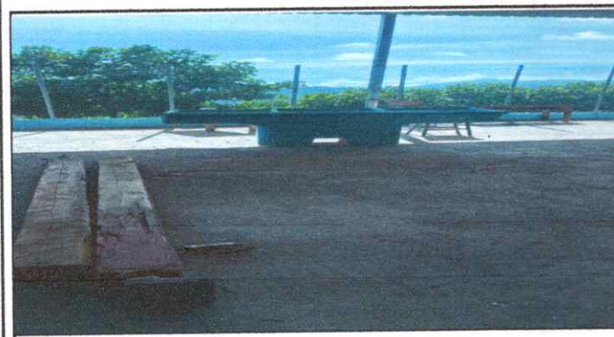
Foto 5: Sustitución de pila.
