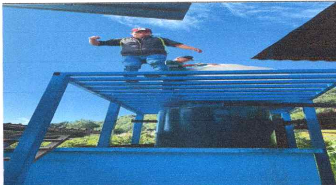
Foto 4: Sustrucción de base de metal, para la estructura del depósito de agua.
