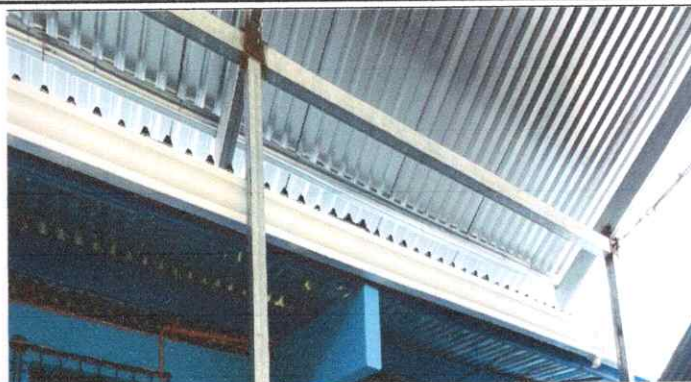
Foto 2: Reparación de agua pluvial.
