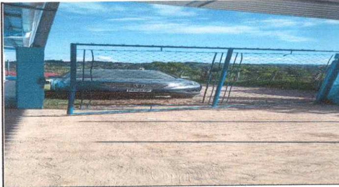
Foto1: Mantenimiento de porton de metal.
