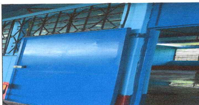
Foto 5: Mantenimiento de puertas de metal.
