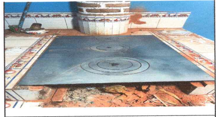
Foto 4: Sustitución de plancha de metal
