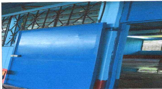
Foto 3: Pintura en muros interiores.
