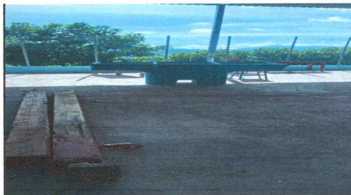
Foto 4: Sustitución de pila.
