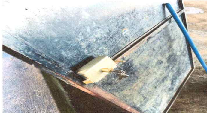
Foto 4: Mantenimiento de puertas de metal.
