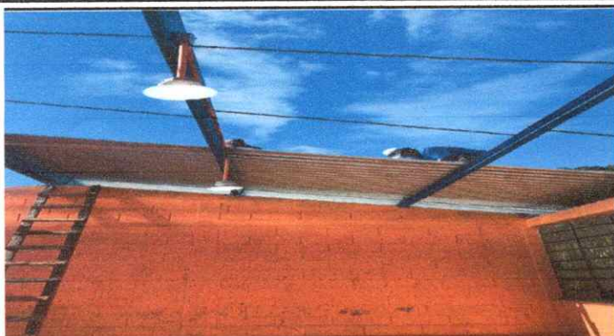
Foto 1: Sustrucción de lámina por lámina troquelada
