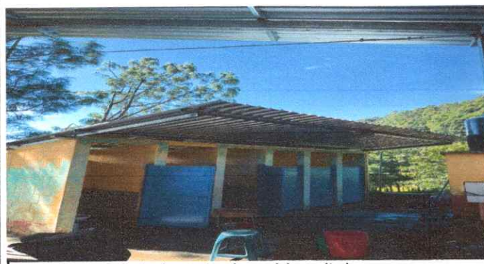
Foto 5: Mantenimiento de puertas de servicio sanitario.
