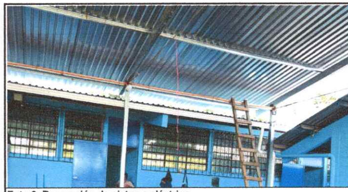
Foto 6: Reparación de sistema eléctrico.
