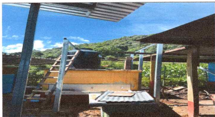
Foto 3: susustrucción de depósito de agua
