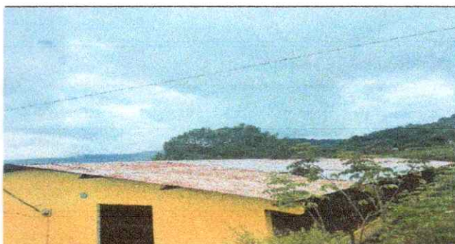
Foto 6: Sustrucción de lámina.
