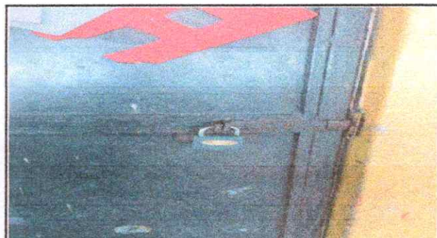
Foto 4: Mantenimiento de puertas de metal.
