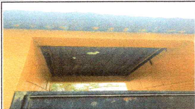
Foto1: Sustitución de láminas.
