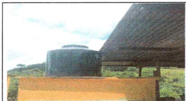
Foto 3: Sustrucción de base por base de metal, para el depósito de agua.
