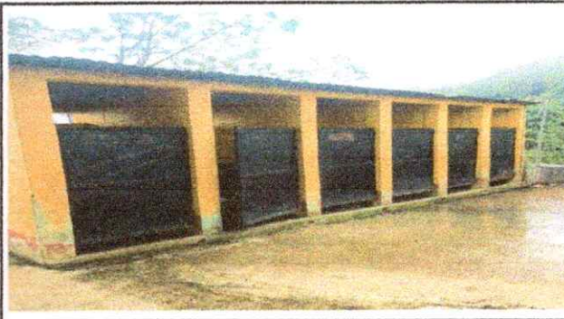
Foto 2: Mantenimiento de puertas de metal.
