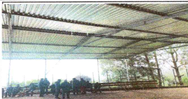
Foto1: Sustrucción de red eléctrica
