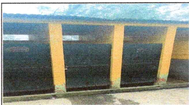
Foto 3: Mantenimiento en puertas de servicios sanitarios.
