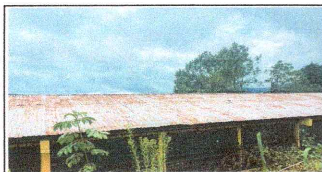
Foto 5: Sustrucción de lámina.
