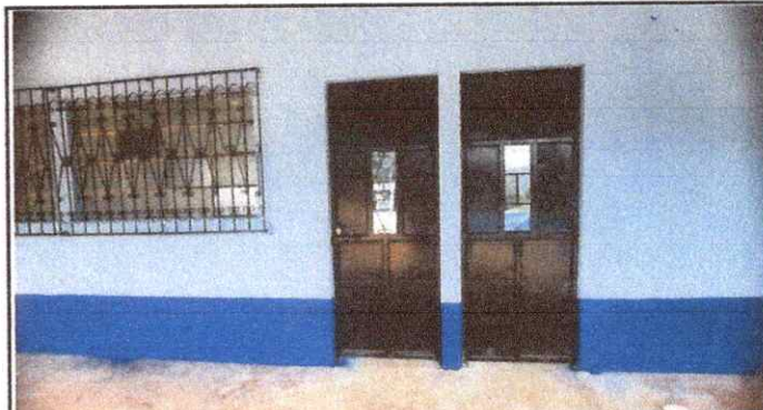
Foto 4: Puertas de metal, mantenimiento a estructura (lijado, cambio de tubo, cepillado, sujeciones, sustitución de chapa, aplicación de pintura)
