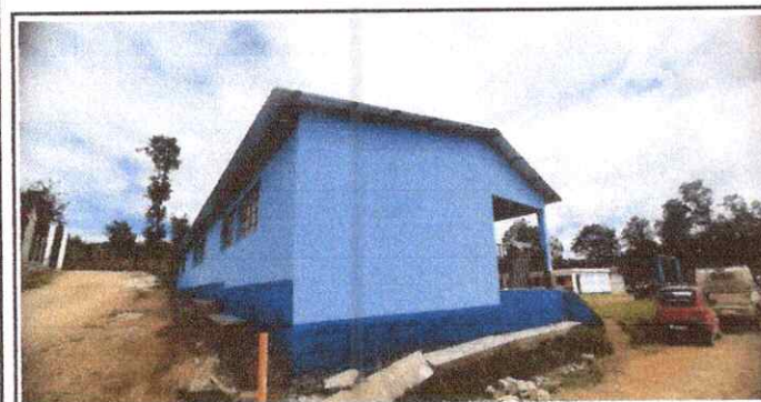
Foto 5: Pintura en muros exteriores e interiores
