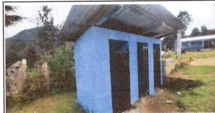
Foto 6: Sustitución de estructura de soporte de madera, por metal, Sustitución de estructura de soporte de madera, por metal (3 servicios sanitarios)
