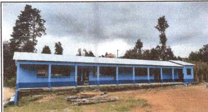
Foto 1: Sustitución de lámina, por lámina troquelada aluzinc calibre 26 (3 aulas, 1 cocina, 1 bodega y 1 dirección)
