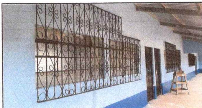
Foto 3: Ventanas, Sustitución de vidrios
