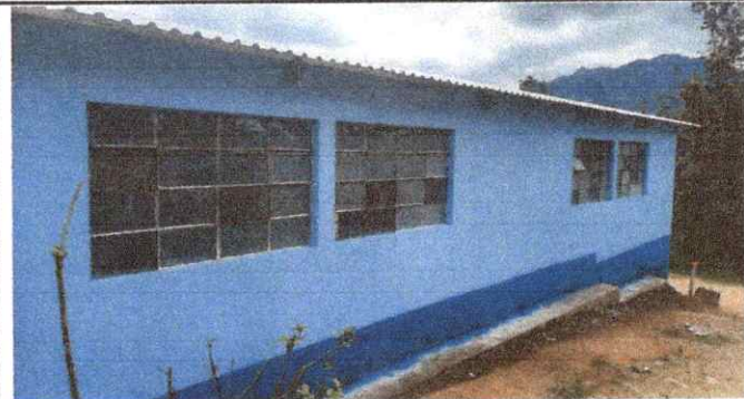
Foto 2: Sustitución de lámina, por lámina troquelada aluzinc calibre 26 (3 aulas, 1 cocina, 1 bodega y 1 dirección)
