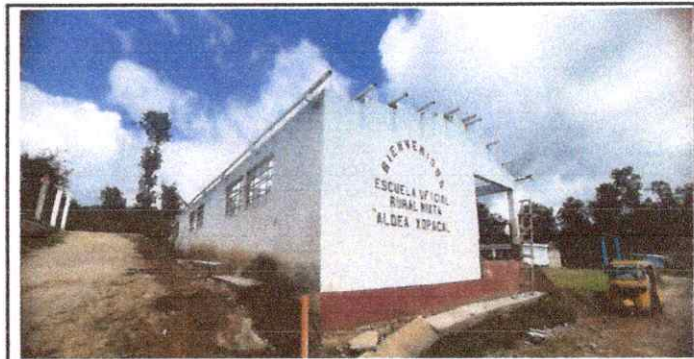
Foto 6: Pintura en muros exteriores e interiores
