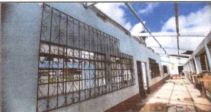
Foto 5: Sustitución de estructura de soporte de madera, por metal (3 aulas, 1 cocina, 1 bodega y 1 dirección)
