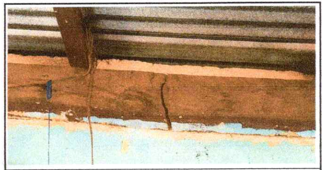
Foto 6: Sustitución de estructura de soporte de madera, por metal (3 aulas, 1 cocina, 1 bodega y 1 dirección)
