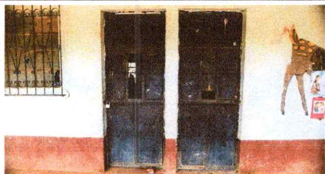
Foto 7: Puertas de metal, mantenimiento a estructura (lijado, cambio de tubo, cepillado, sujeciones, aplicación de pintura)
