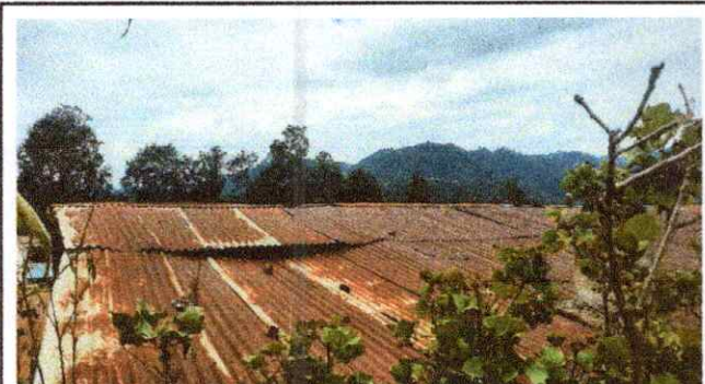
Foto 3: Sustitución de lámina, por lámina troquelada aluzinc calibre 26 (3 aulas, 1 cocina, 1 bodega y 1 dirección)
