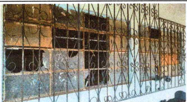
Foto 9: Ventanas, sustitución de vidrios
