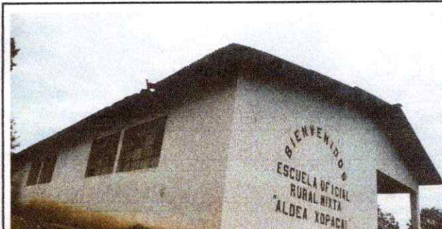
Foto 12: Pintura en muros exteriores e interiores
