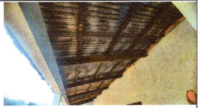
Foto 4: Sustitución de estructura de soporte de madera, por metal (3 aulas, 1 cocina, 1 bodega y 1 dirección)
