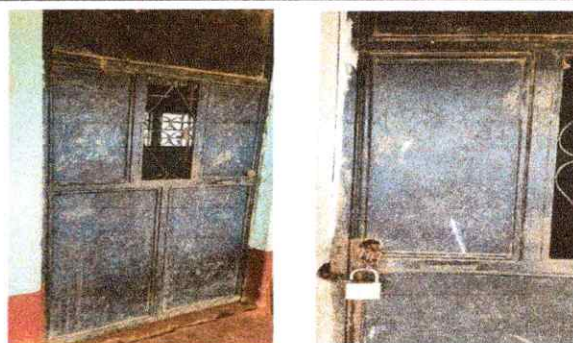
Foto 8: Puertas de metal, mantenimiento a estructura (lijado, cambio de tubo, cepillado, sujeciones, aplicación de pintura)
