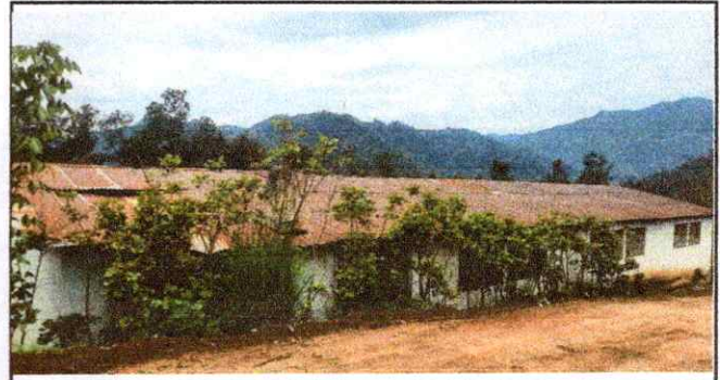
Foto 2: Sustitución de lámina, por lámina troquelada aluzinc calibre 26 (3 aulas, 1 cocina, 1 bodega y 1 dirección)
