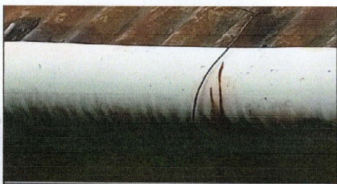
Foto 5: SUSTITUCION DE CANAL DE PVC, POR PVC 4"
