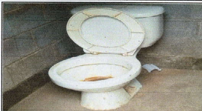
Foto 7: SUSTITUCION DE INODORO Y DE ACCESORIOS
