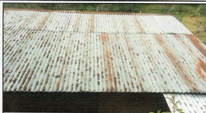
Foto1: Sustrución de lamina ondulada por lamina troquelada Maxalum, Calibre 26. color gris metalico.
