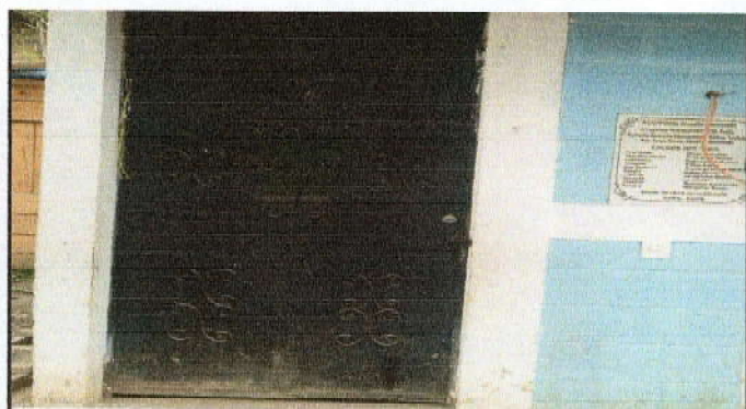
Foto 3: SUSTITUCION DE PUESTRA DE METAL
