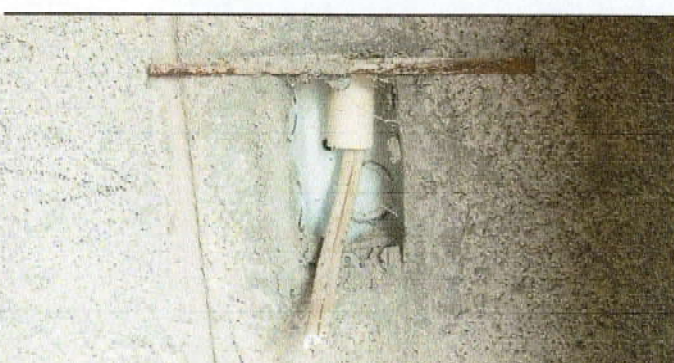
Foto 12: MANO DE OBRA ESPECIALIZADA
