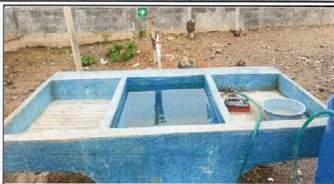
Foto 8: REPARACION DE RED DE DRENAJE Y RED DE AGUA
