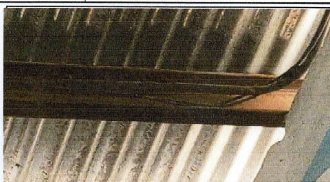
Foto 2: SUSTITUCION DE ESTRUCTURA DE SOPORTE DE METAL NEGRO POR METAL GALVANIZADO
