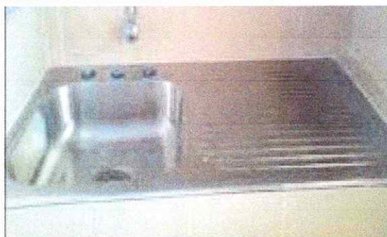
Foto 10: Sustitución de lavatrastos (incluye mezcladora)
