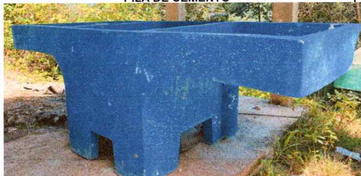
Foto 9: Sustitución de pila de cemento de dos lavaderos
