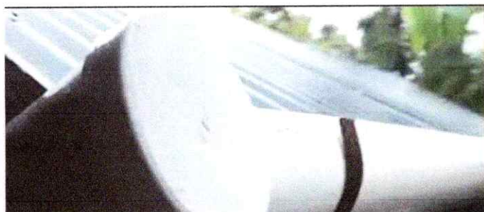
Foto 8: Mejoramiento de canal de pvc (tubos, codos, tee)
