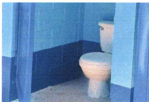
Foto 3: Sustitución de inodoros con accesorios completos.
