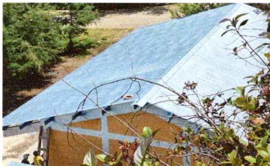
Foto 1: Sustitución de lámina ondulada, por lámina troquelada aluzinc calibre 26 color gris metálico, capotes y elementos de fijación. También instalación de canal de PVC.
