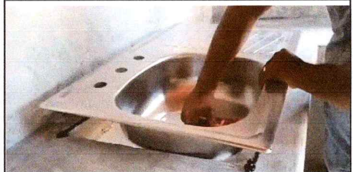
Foto 10: Sustitución de lavatrastos (incluye mezcladora)
