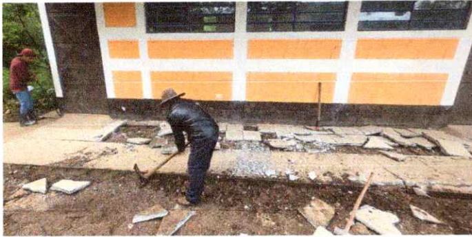
Foto7: Sustición de piso de granito por piso de granito
