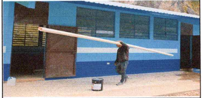
Foto 8:Mejoramiento de canal de pvc (tubos, codos, tee)
