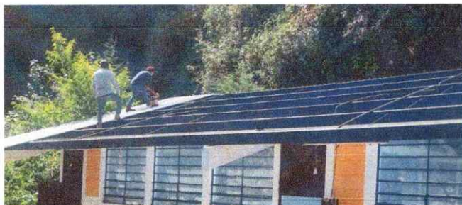
Foto 1: Sustitución de lámina ondulada, por lámina troquelada aluzinc calibre 26 color gris metálico, capotes y elementos de fijación. También instalación de canal de PVC.
