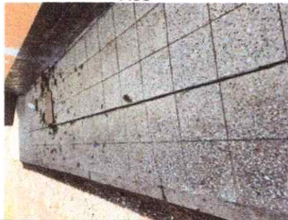
Foto 7: Sustitución de piso de granito por piso de granito
