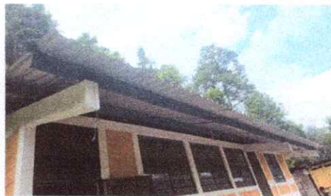
Foto 8: Mejoramiento de canal de pvc (tubos, codos, tee)
