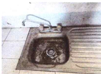
Foto 10: Sustitución de lavatrastos (incluye mezcladora)
