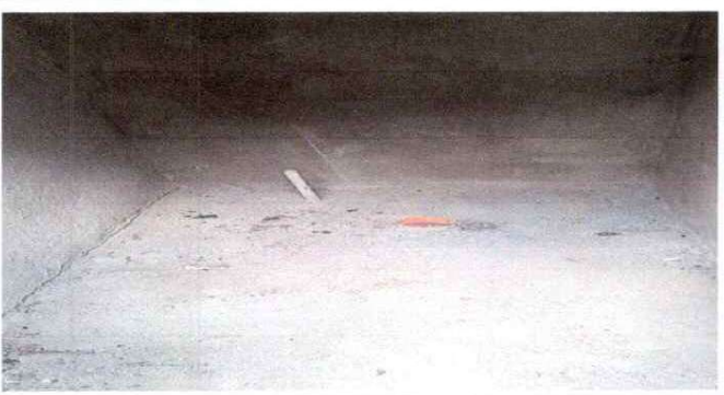
Foto 9: CUNETA DE CONCRETO
