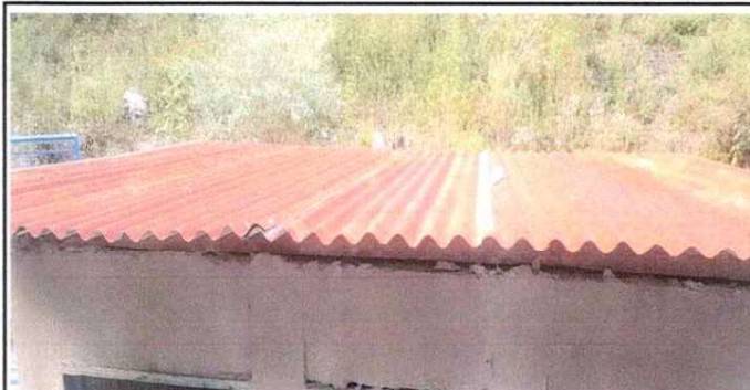
Foto 2: ESTRUCTURA DE TECHO (Aula, cocina)
