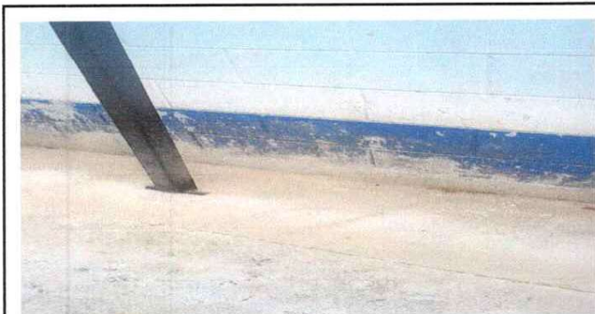
Foto 5: PINTURA EN MUROS EXTERIORES E INTERIORES
