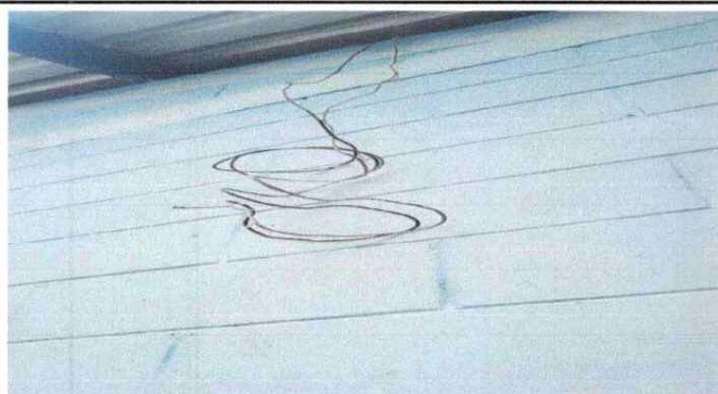
Foto 7: SISTEMA ELÉCTRICO (Y ACCESORIOS)
