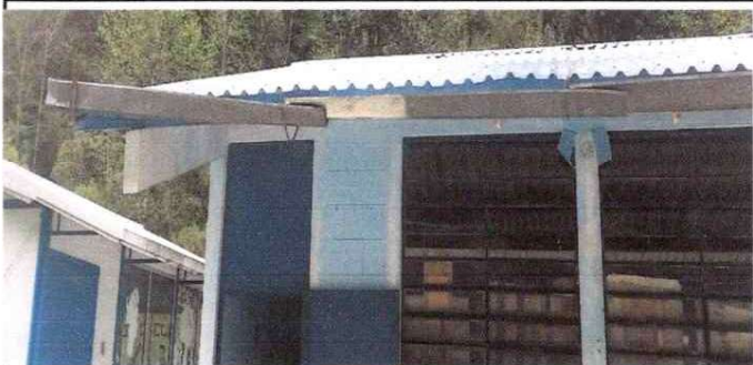
Foto 4: CANALES Y BAJADAS DE AGUA PLUVIAL (3 AULAS)
