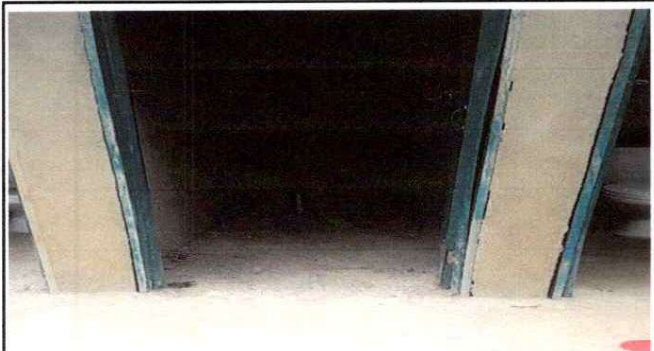
Foto 3: PUERTAS DE METAL (Aulas + Cocina + baños).
