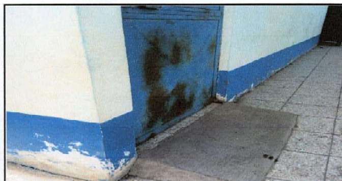
Foto 6: PINTURA EN MUROS EXTERIORES E INTERIORES
