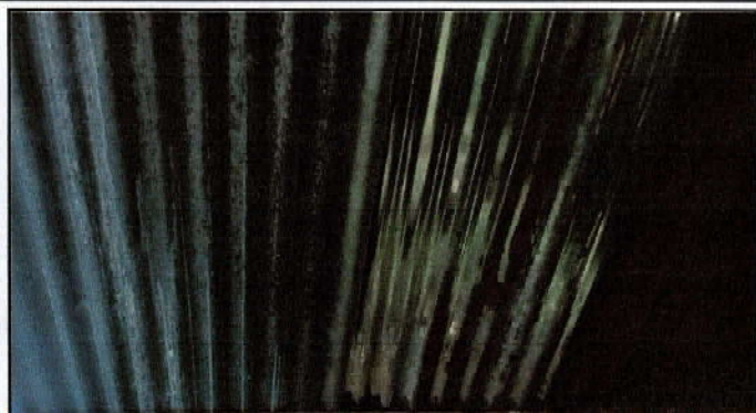
Foto1: CUBIERTA DE LAMINA - TECHO 1 AGUA (BAÑOS, 1 BASE EST. TINACO)
