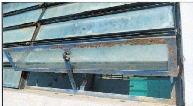
Foto 4: VENTANAS (2 AULAS + 1 COCINA).
