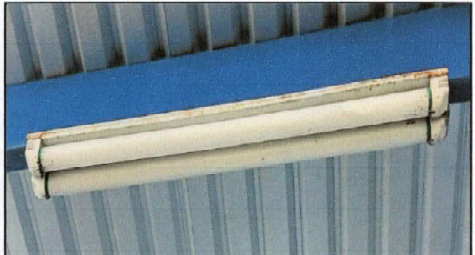
Foto 10: SISTEMA ELÉCTRICO (Y ACCESORIOS)
