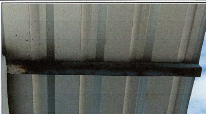
Foto 2: ESTRUCTURA DE TECHO - 1 AGUA (BAÑOS Y BASE EST. DE TINACO)
