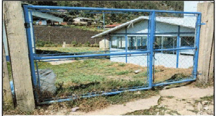
Foto 8: MANTENIMIENTO A PORTONES (1 PORTON PRINCIPAL)
