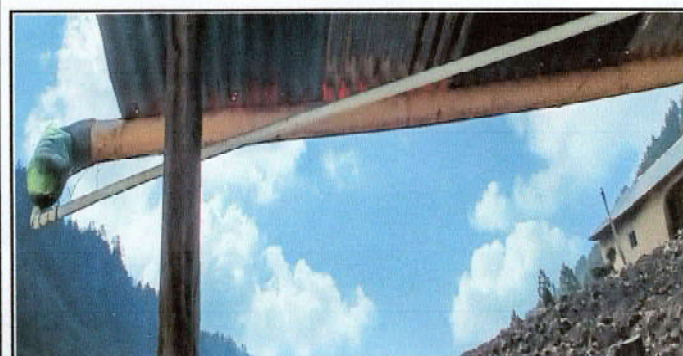
Foto 5: CANALES Y BAJADAS DE AGUA PLUVIAL (3 AULAS)
