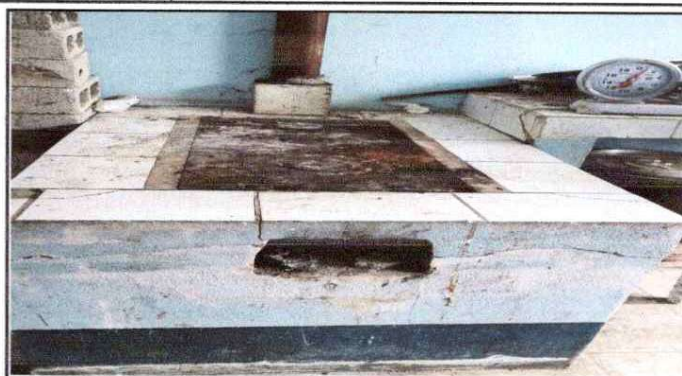
Foto 8: REPARACION DE COCINA
