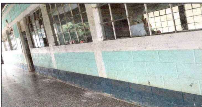
Foto 5: PINTURA EN MUROS EXTERIORES E INTERIORES
