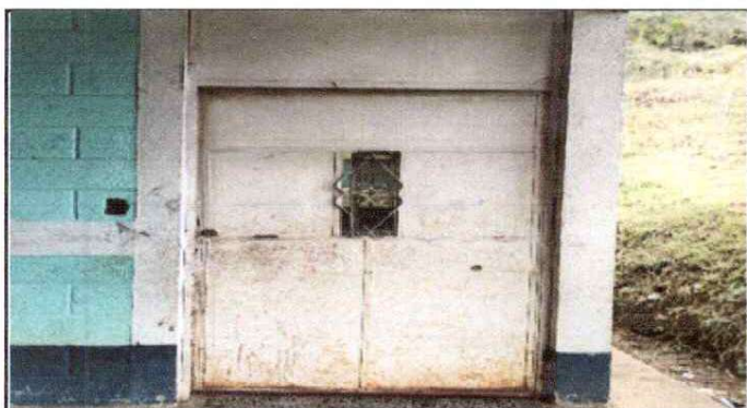
Foto 3: PUERTAS DE METAL (Aulas + Cocina + baños).
