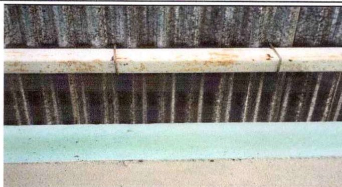
Foto 2: ESTRUCTURA DE TECHO (Aulas con corredores)
