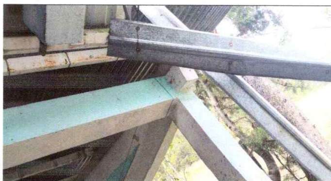
Foto 4: CANALES Y BAJADAS DE AGUA PLUVIAL (3 AULAS)
